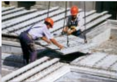
Höhenkirchen bei München, Neubau von Mehrfamilienhäusern
