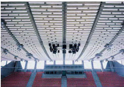
Hängesystem Absorber Rondo im Stadion
