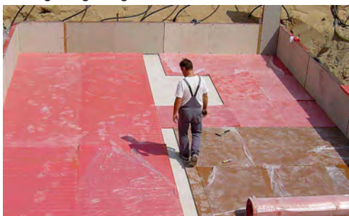
Flächige Lagerung beim Hausbau
