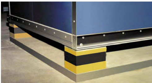
Lagerung eines Klimageräts im Obergeschoß
